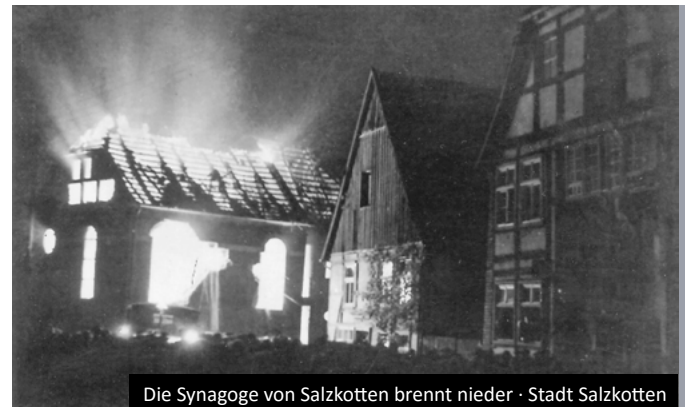
Die Synagoge von Salzkotten brennt nieder · Stadt Salzkotten
