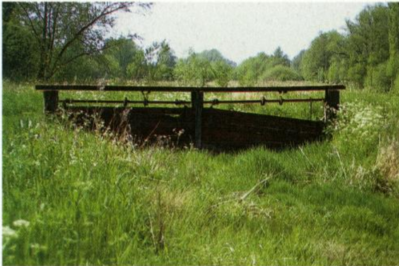
Blick in die Heinz-Nixdorf-Aue mit dem alten Haupteinlaßwehr
