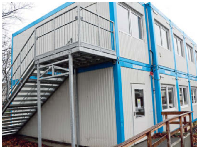
An der Stephanusschule wird mehr Raum benötigt, der übergangsweise durch weitere Container wie diese geschaffen werden soll.
