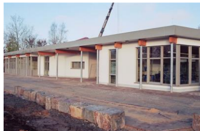
Errichtung der OGS 2005
