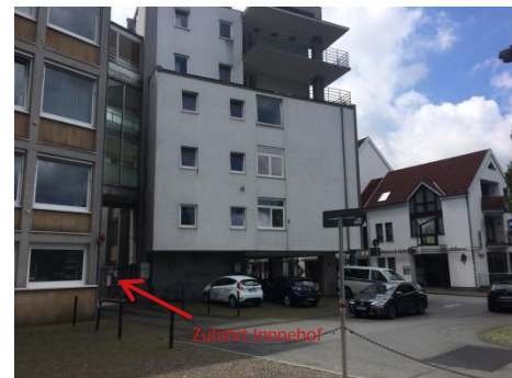
Zufahrt zum Innenhof
