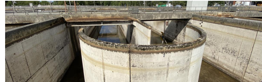
Belebungsbecken Biologie 2 in entleertem Zustand
