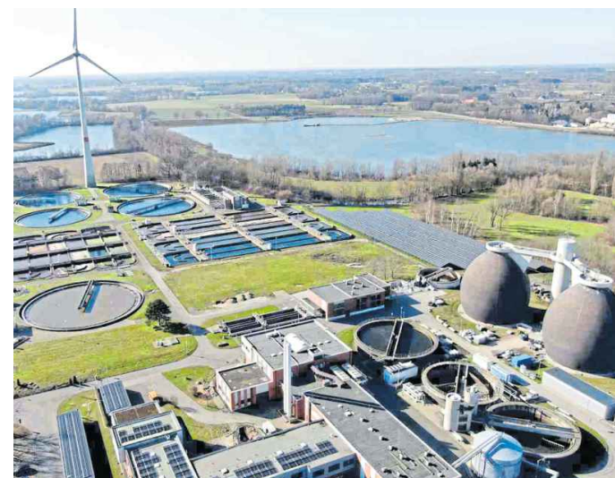
Aufgrund gestiegener Kosten muss der Stadtentwässerungsbetrieb (STEB) – hier die Kläranlage in Paderborn-Sande – die Gebühren für das Abwasser und das Niederschlagswasser im kommenden Jahr erhöhen.
