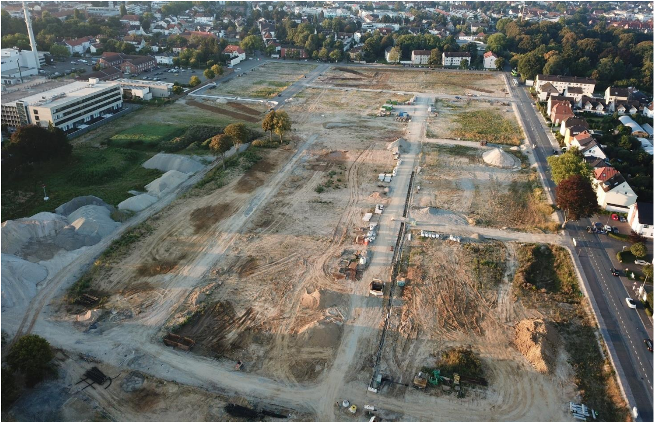
Aktueller Baufortschritt Alanbrooke Quartier (Quelle: Andreas Lampe)
