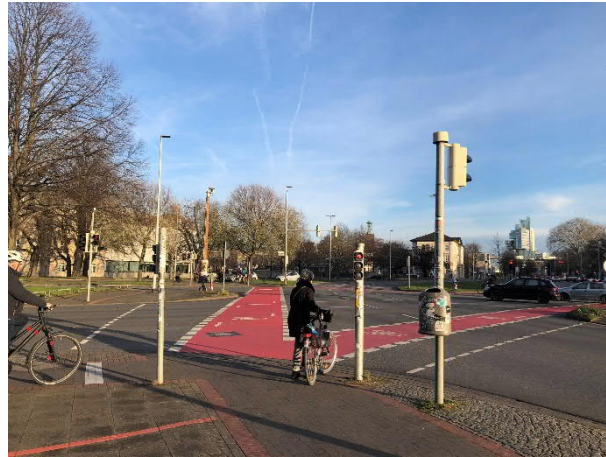
Abb. 31 Flächenhafte rote Markierung von Radfurten und Ergänzung Signalgeber für den Radverkehr (Hannover)
