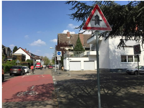
Abb. 37 Vorfahrt im Zuge einer Fahrradstraße mit flächenhafter roter Markierung der Fahrbahn (Mannheim)
