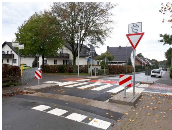
Abb. 36 Aufpflasterung mit Fußgängerüberweg (Paderborn) 40
