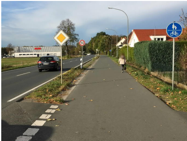
Abb. 13 Beispiele für Radverkehrsführung nach dem Trennungsprinzip (links: Gemeinsamer Geh- und Radweg) und Teilseparation (rechts: Radschutzstreifen)
