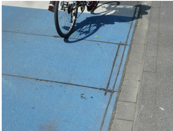
Abb. 16 Detektion Radfahrender mit Induktionsschleifen
