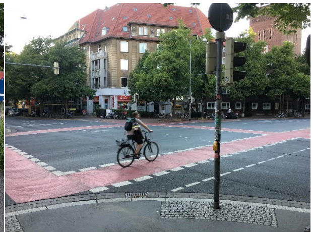
Flächenhafte Roteinfärbung von Radfurten an einem signalisierten Knotenpunkt
