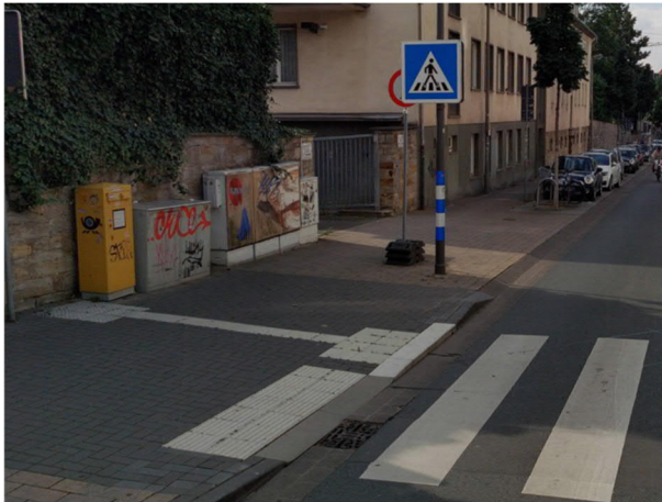
Abb. 10 Beispiele Einsatz von taktilen Leitelementen und differenzierten Bordhöhen an einem Fußgängerüberweg (links), Vorhandensein von Sitzmöglichkeiten (rechts) 19
