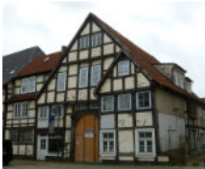
Giebelständiges Satteldach
